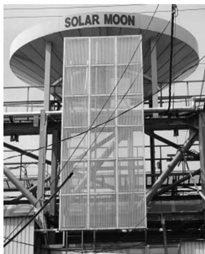
写真 2 アーケード上のソーラー施設
